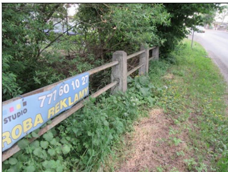
Zábradlí vpravo - havarijný stav pohled proti směru staničení Rozpadlé resp. chybějící betonové sloupky, uvolněné ocelové trubky výplně. Zarostlá římsa a nezpevněná krajnice
