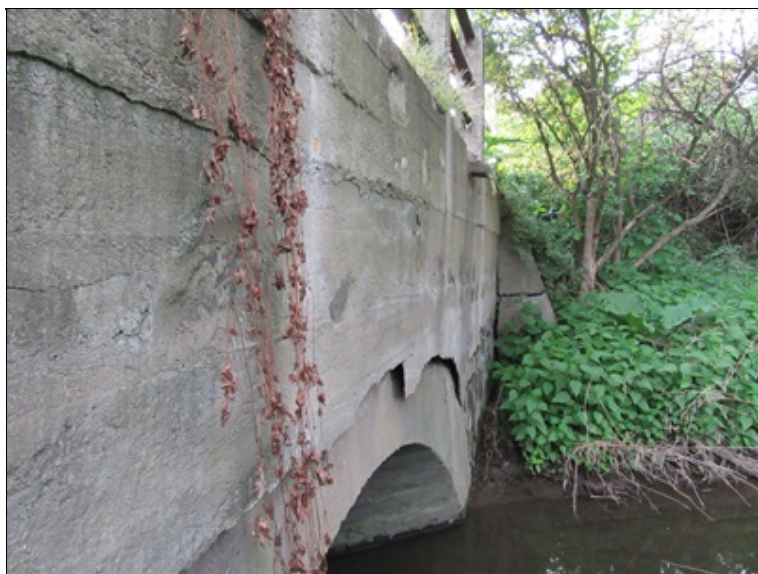
Pohled na levou stranu - trhlina v čelní zdi pokračuje do křídla OP1 a do výztužného žebra a dále do opěrné zdi.
