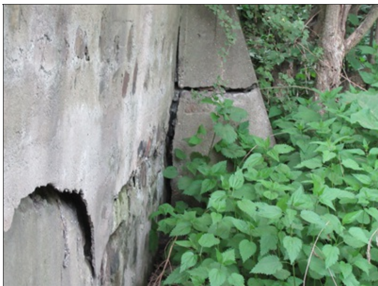
Pohled na levou stranu - trhlina v čelní zdi pokračuje do křídla OP1 a do výztužného žebra a dále do opěrné zdi. Spodní část žebra se již utrhla
