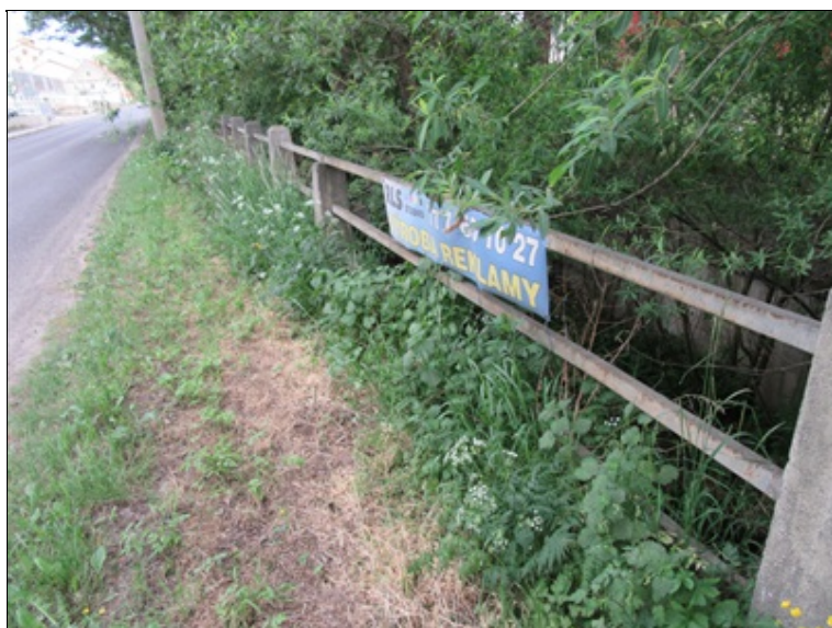
Zábradlí vpravo - havarijný stav Rozpadlé resp. chybějící betonové sloupky, uvolněné ocelové trubky výplně. Zarostlá římsa a nezpevněná krajnice
