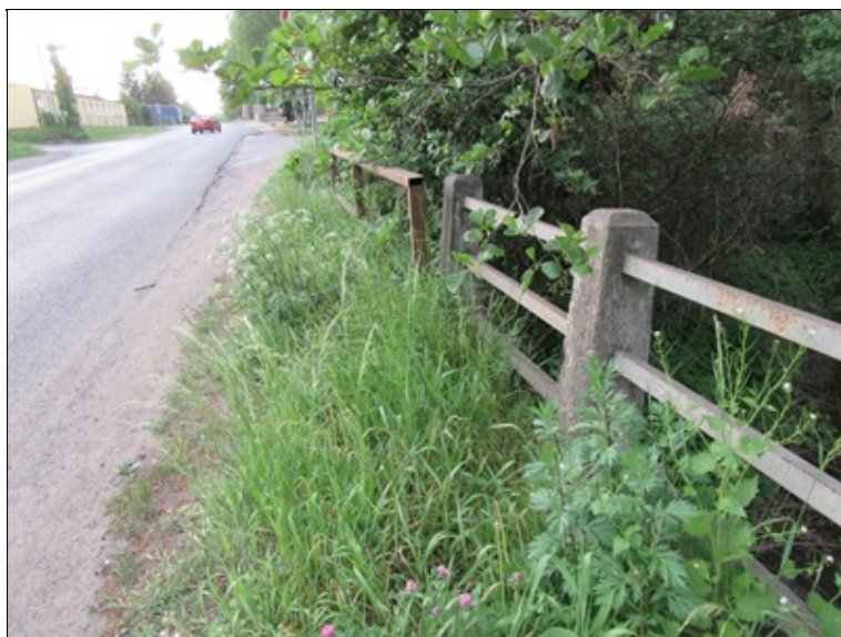
Zábradlí vlevo - havarijní stav Výrazně vykloněné vnějším směrem Zarostlá římsa a nezpevněná krajnice
