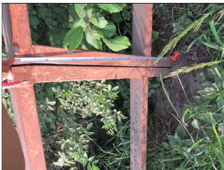
Zábradlí vlevo Vychýlené sloupky ocelového zábradlí v podélném směru - uvolněné betonové bloky kapes zakotvení v římsě.
