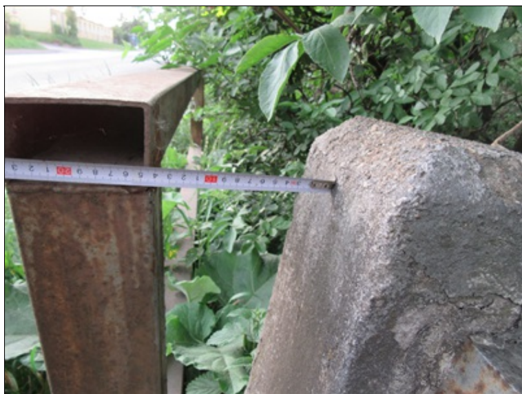
Zábradlí vlevo - havarijní stav Výrazně vykloněné vnějším směrem - naměřeno cca 15 cm.
