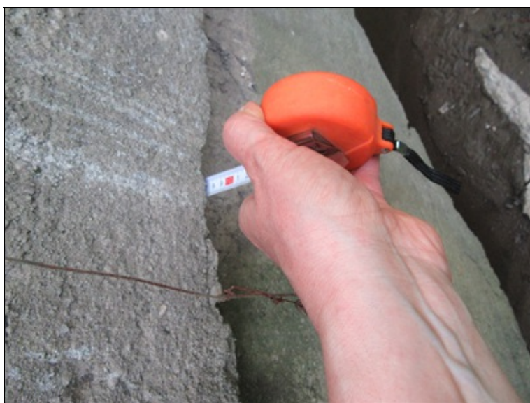
LS Detail vychýlení čelní zdi vzhledem k boku klenby Měření výchylky v dostupném místě- naměřeno 70 mm.
